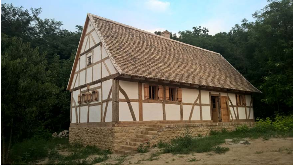
Závod, Zrínyi utca, rekonstruált első generációs fachwerk lakóház (Fotó Szász Gábor)
